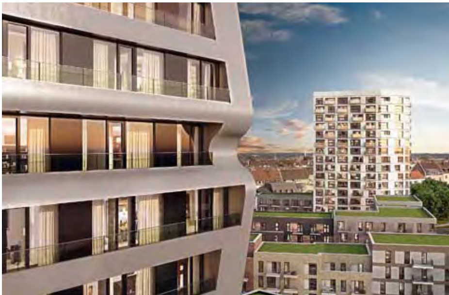
Moderne Wohntürme, die sich gut in das bestehende Quartier einfügen, können das soziale Leben bereichern
