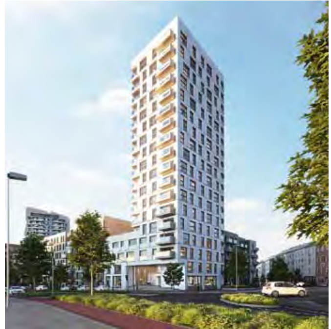
Aus nachhaltigen Gesichtspunkten bieten Wohntürme viele Vorteile
